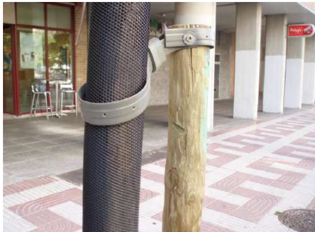
Imagen75.Colocación adecuada de tutor y malla antifendas
