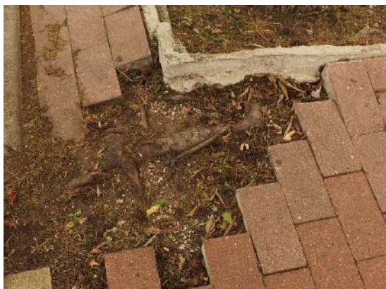
Imagen40. Sistema radicular levantando el pavimento en C/Ezkaba.
