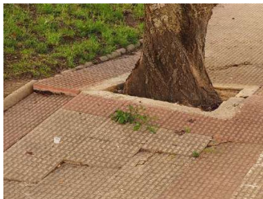
Imagen41. Levantamiento pavimento C/Lerín.
