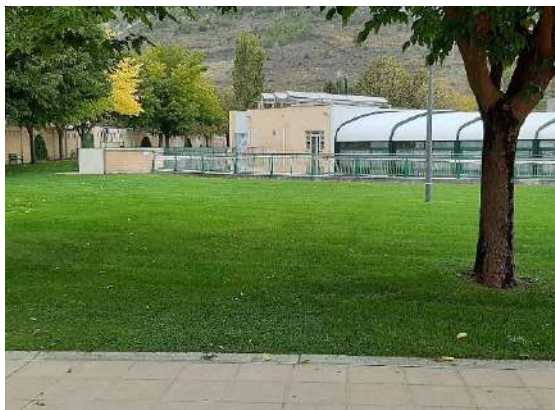
Imagen46. Césped en buen estado piscinas.
