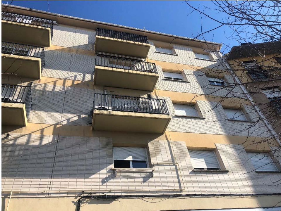
Detalle de la fachada a vía pública
