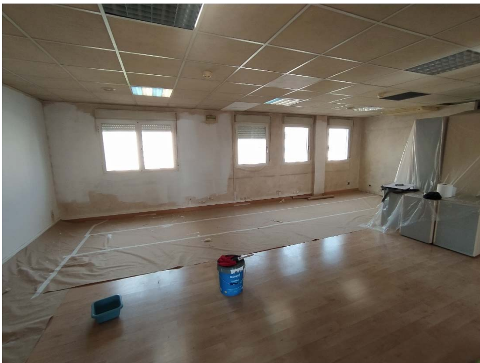
Detalle del interior de la actual oficina
